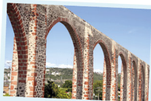
Acueducto de Querétaro
